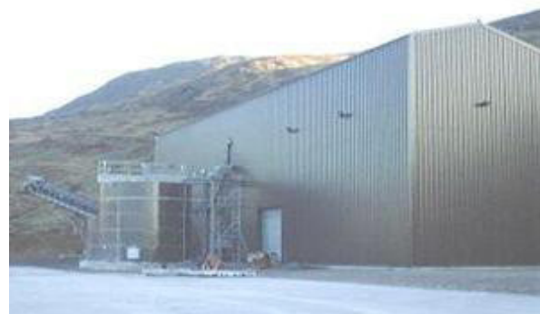
Sitio de desagüe de la pulpa
